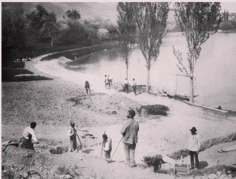
Häufig wurden Patienten bei Bauarbeiten eingesetzt – hier beim Wasserleitungsbau für die Klinik Rheinau.
